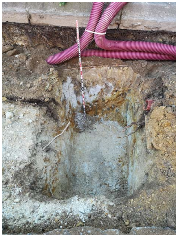
Fig.14 Detall del retall per a la fonamentació del fanal 2
