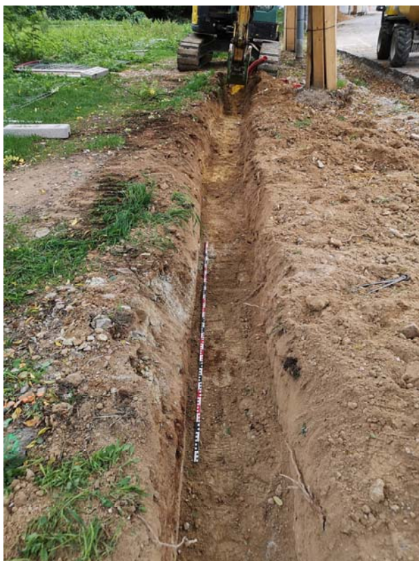
Fig.16 Detall del procés de rebaix de la rasa de serveis 1
