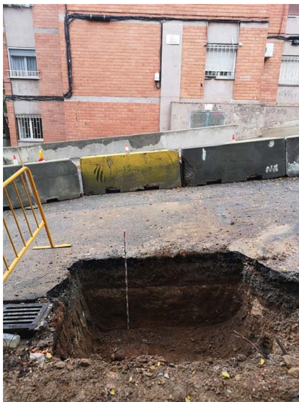
Fig.10 Detall de la rasa per a la construcció d'un embornal en la part sud del carrer de la Foneria
