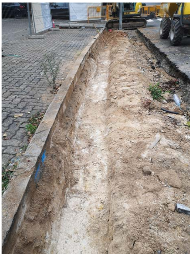
Fig.11 Detall de la rasa pel pas de cablejat elèctric al tram II, s'aprecia l'estrat de nivellament UE 202 i les argiles blanques UE 203 .
