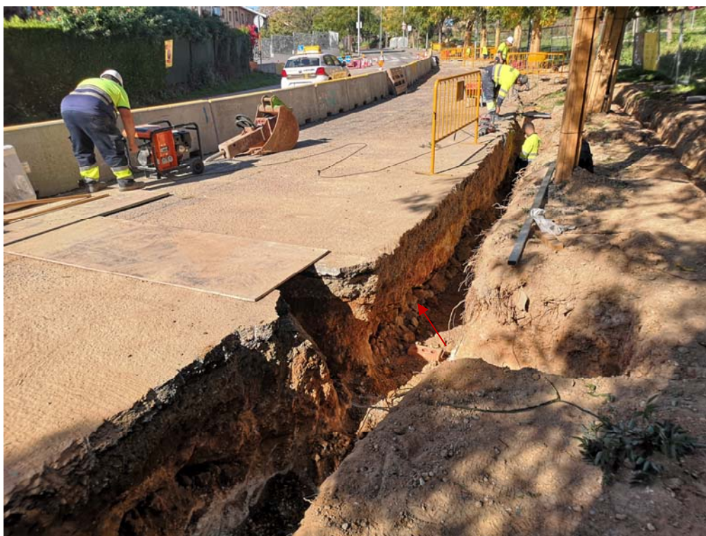
Fig.17 Detall de la rasa de serveis III, amb l'estrat d'enderroc UE 409
