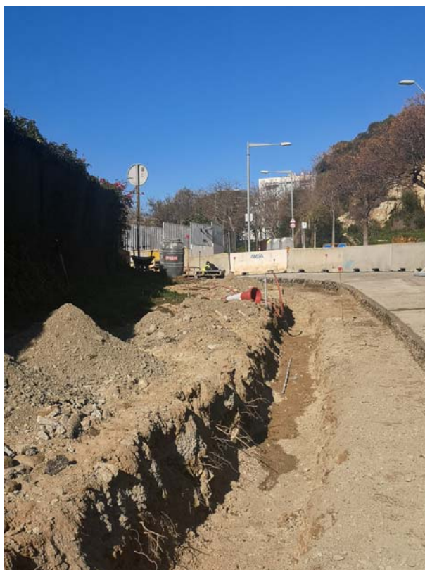
Fig.22 Detall de l'estratigrafia de la rasa de serveis al tram VII. S'aprecia la superposició de la capa d'asfalt, la seva preparació, el nivell d'argiles i el natural.
