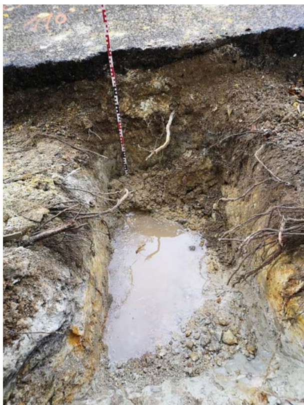
Fig.15 Detall del retall per a la fonamentació del fanal 4
